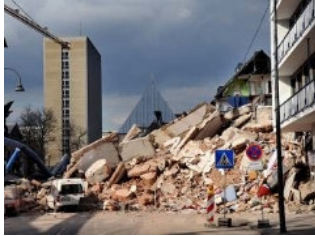
Werden die Schäden des Archiv-Einsturzes verharmlost?
